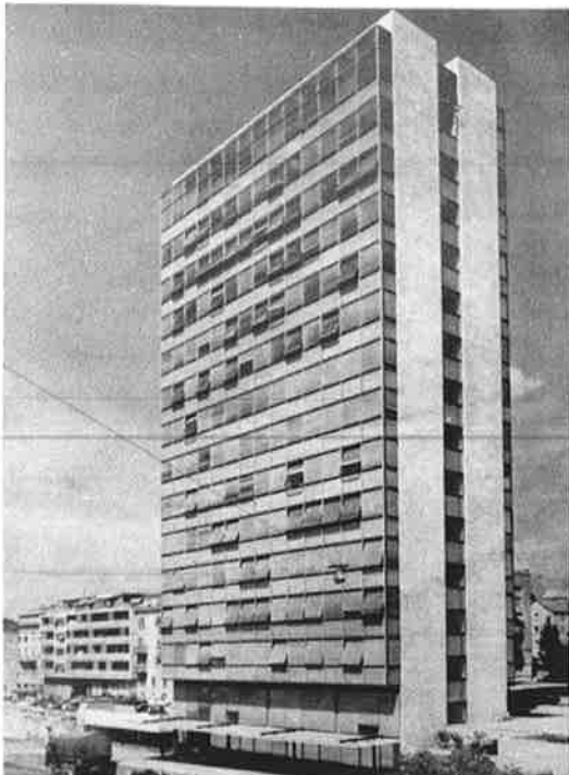
- izvorni izgled nebodera prije rekonstrukcije i zamjene pročelja, vidljivi otklopni prozori s vanjskim brisolejima
